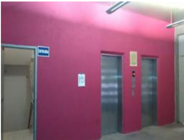
Reparación de afectaciones
