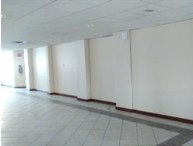
Reparación de afectaciones
