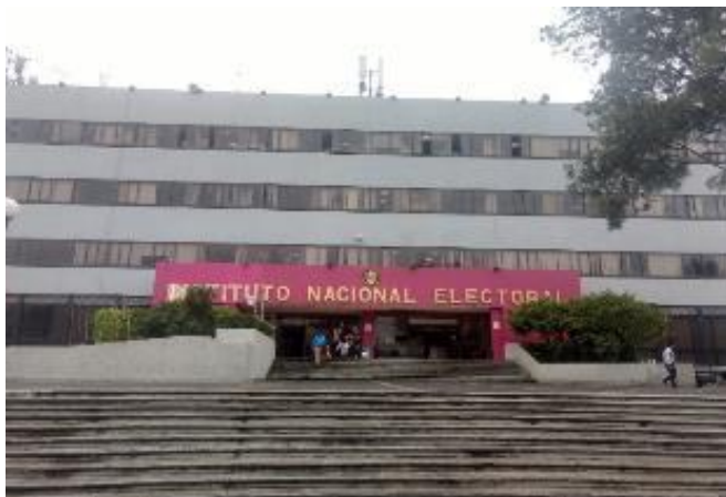
Remozamiento de fachadas
