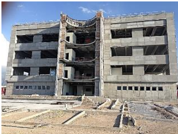
Trabajos en fachadas del edificio
