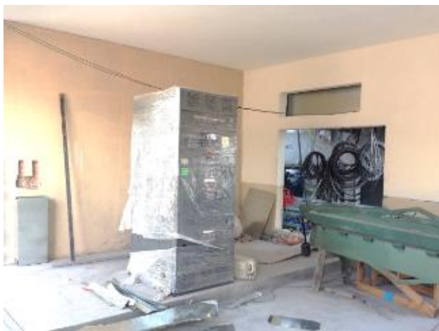
Trabajos al interior y exterior del edificio
