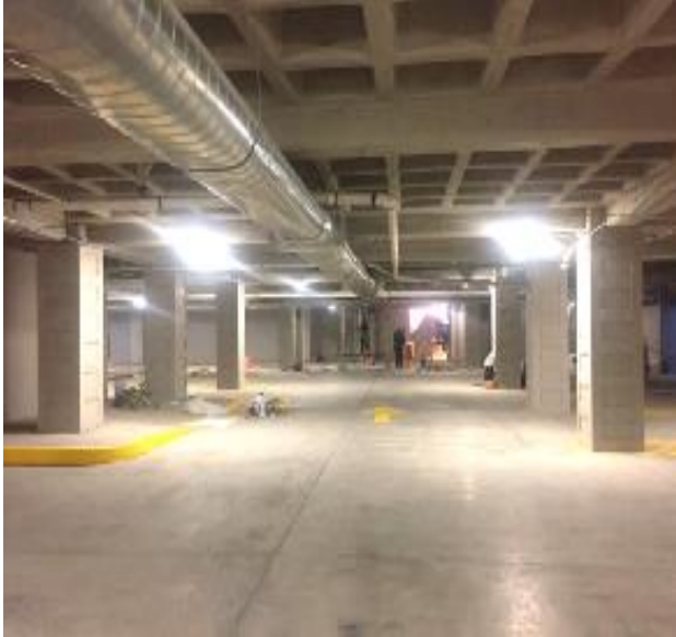
Reparación de afectaciones
