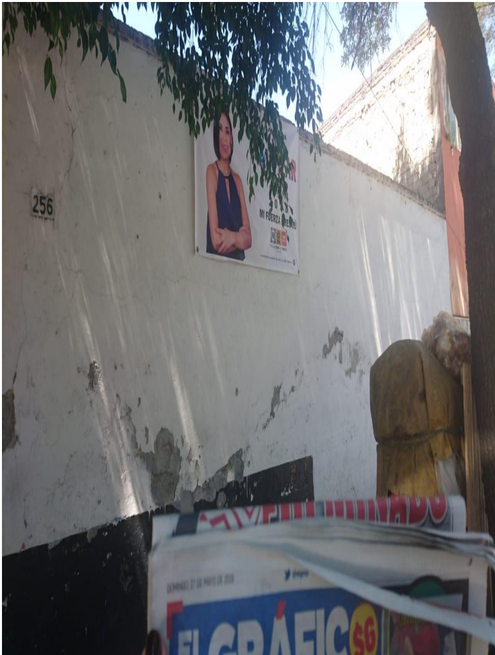
Imagen 367. CALLE 27 ENTRE CALLE 10 Y CALLE 12 SECCIÓN 323, Colonia Pro-Hogar, C.P. 02600, Azcapotzalco, Ciudad de México, 27 de mayo de 2018, Manta tipo 1.
