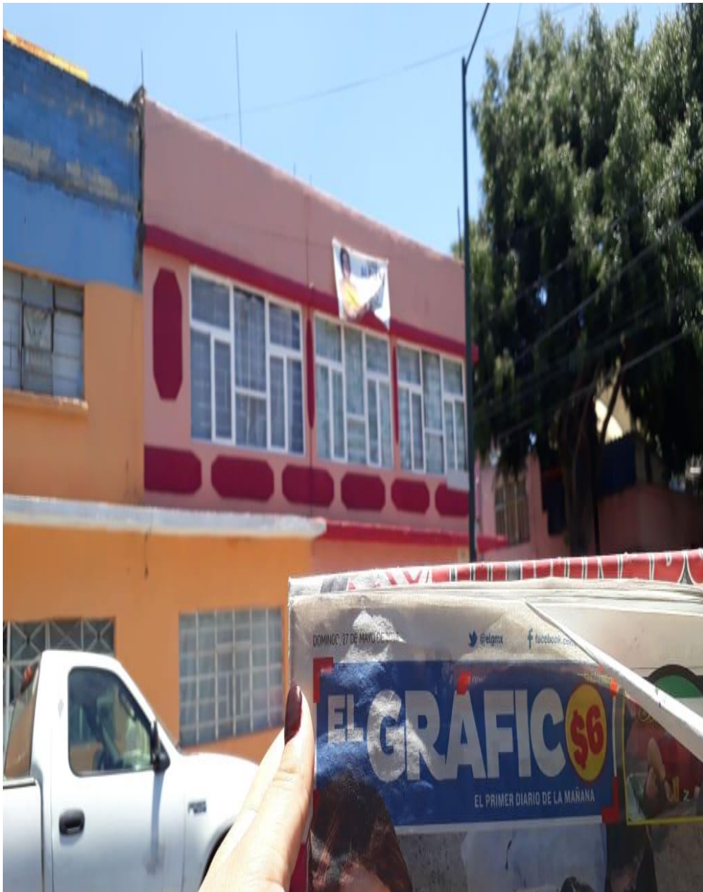
Imagen 651. Calle Toronjil No. 36, entre Caimito y Jícama, Sección 0031, Colonia Victoria de las Democracias, C.P. 02810, Azcapotzalco, Ciudad de México, 27 de mayo de 2018, Manta tipo 2.
