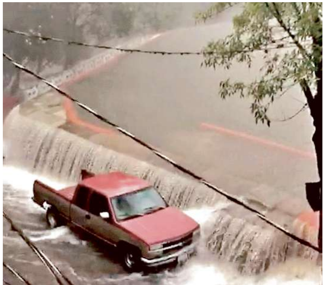
RIESGO. Automovilistas cruzaron cerca de la Presa de la Olla cuando comenzó a desbordarse.
