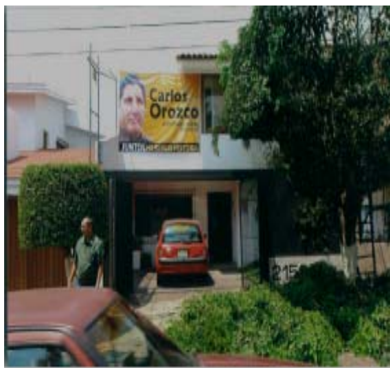
Manta casa de enlace
