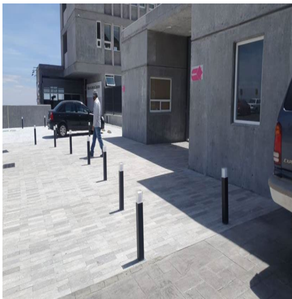
Plaza de Acceso, Exteriores
