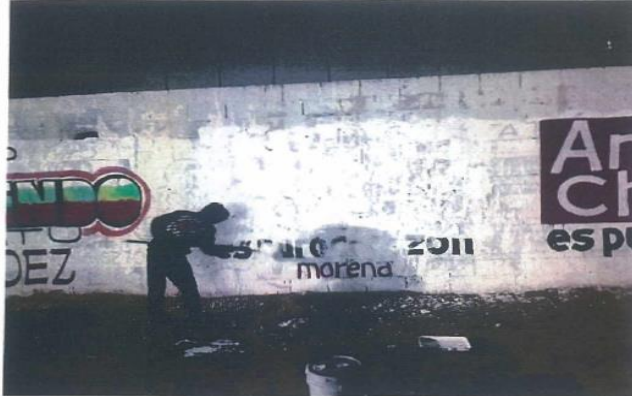
Inicio de trabajo de blanqueamiento de barda
