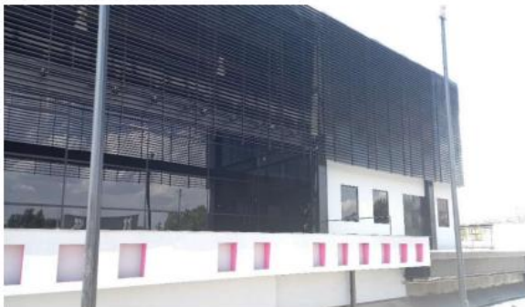
APLICACIÓN DE PINTURA DE ESMALTE FLASH COAT EN SOLERAS DE FACHADA Y EN ESTRUCTURA METALICA EN EXTERIOR EN ZONA DE COMEDOR Y ANDEN DE DESCARGA.
