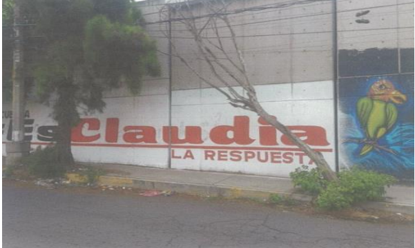
Barda No. 1 (Calle Emiliano Zapata)
