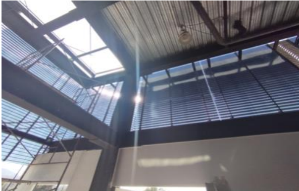
Policarbonato en Fachada
