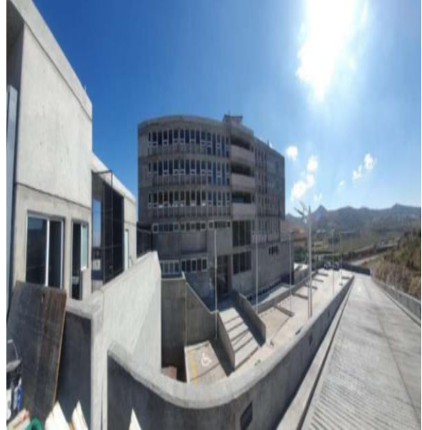
Acceso Estacionamiento, Exteriores
