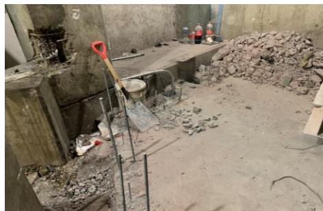
Demolición en Foso del Montacoches
