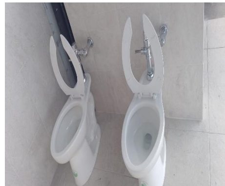
Instalación de muebles en área de baños
