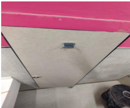
Colocación de mamparas en baños
