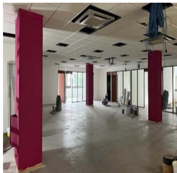
Aplicación de pintura en muros y plafones
