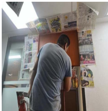
Mantenimiento a puertas de madera
