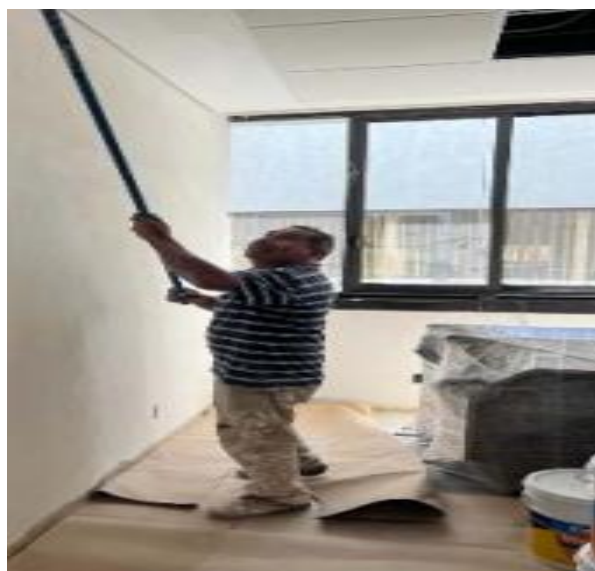
Aplicación de pintura en muros y plafones
