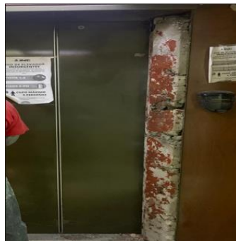
Desmontaje y desinstalación de Elevador 2
