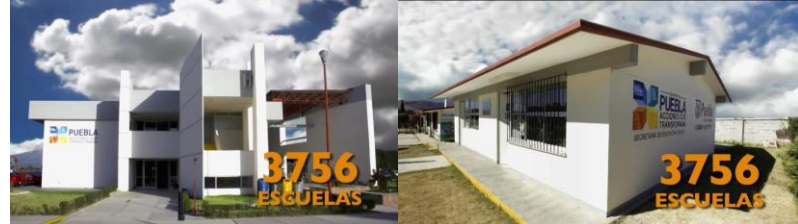
Hemos construido y modernizado tres mil setecientos cincuenta y seis escuelas
