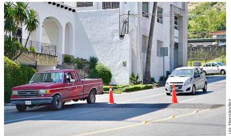
Dos bordos fueron instalados supuestamente por Caminos y Puentes Federales sobre la Avenida San Francisco, para facilitar la entrada y salida de su personal.
