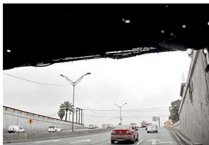
La estructura inferior del Puente Pino Suárez tiene las varillas expuestas ante los constantes golpes que recibe de los camiones que pasan por la Av. Constitución.
