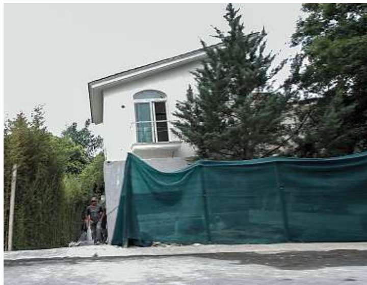
La residencia que compró el Gobernador Rodrigo Medina en el club de golf Las Misiones está siendo remodelada.
