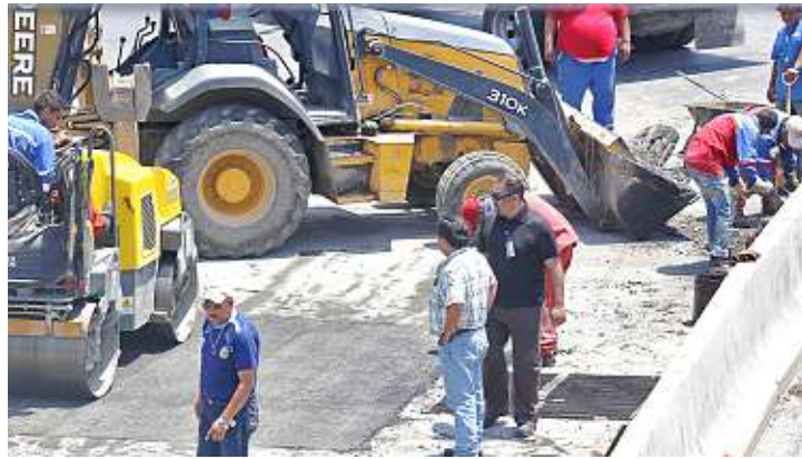
Trabajadores de Servicios Públicos retiran rejillas de un pluvial de Garza Sada, lo que provoca caos y molestia de automovilistas.
