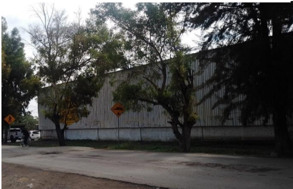
# 31 CALLE PINO SUAREZ, ZONA CENTRO DE ROMITA, GTO. EN LA CONTRA ESQUINA DE UNA TIENDA DE ABARROTOS, EN LA SALIDA AL CAMINO HACIA LA COMUNIDAD DE SAN CLEMENTE
