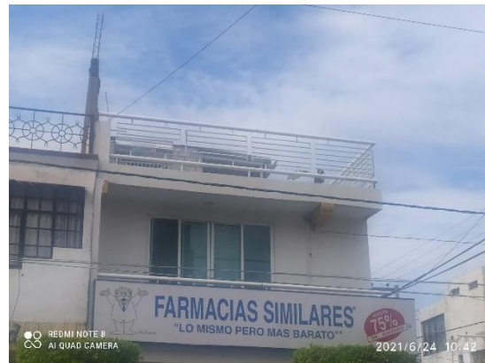
# 327 CALLE IGNACIO ALLENDE, ESQUINA CON CALLE BERRIOZBAL, ZONA CENTRO DE ROMITA, GUANAJUATO
