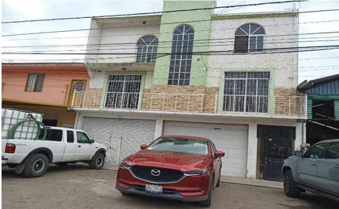
#213 EN INICIO DE CARRETERA ROMITA – TEJAMANIL, FRENTE AL PARQUE MUNICIPAL, AL LADO DE UNA TIENDA DE ABARROTES.
