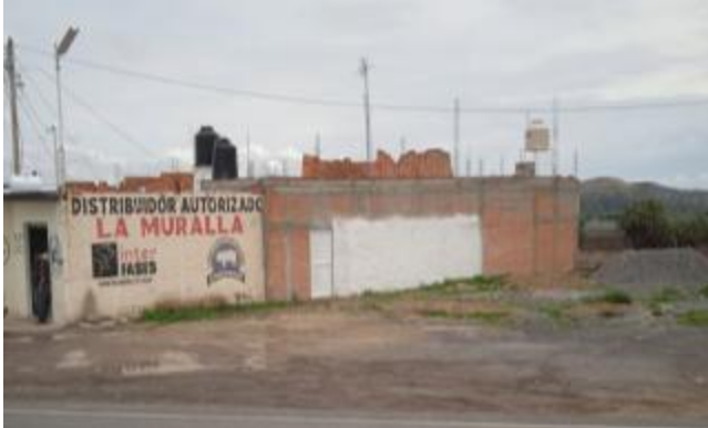
# 8 CAMINO REAL, A UN LADO DEL DISTRIBUIDOR DE ALIMENTOS, EN LA COMUNIDAD DE LA MURALLA, FRENTE A LA VULCANIZADORA EL ABUELO, ROMITA, GUANAJUATO
