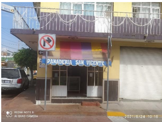
# 332 EN LA PARTE SUPERIOR DE UN NEGOCIO DE PANADERÍA, UBICADA EN CALLE 16 DE SEPTIEMBRE, ESQUINA CON BERRIOZABAL, ZONA CENTRO DE ROMITA, GUANAJUATO
