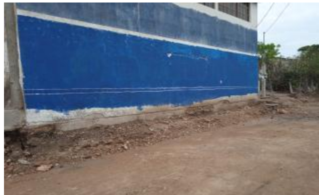
#111 CALLE PRINCIPAL, DEL LADO DERECHO, COMO REFERENCIA, EL DOMICILIO ERA UNA TIENDA ANTERIORMENTE, CASA DE DOS PISOS, COMUNIDAD DE SANTA ROSALÍA DE GAVIA, ROMITA, GUANAJUATO
