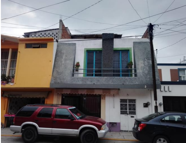
# 293 PARTE SUPERIOR DE UNA TIENDA DE ROPA, UBICADA EN CALLE HERRERA, NUMERO 31, ZONA CENTRO, ROMITA,
