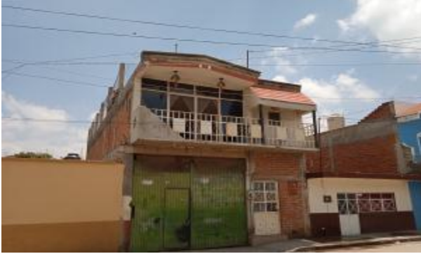
#173 CALLE NICOLAS BRAVO S/N, ENTRE CORONADO Y VILLAGOMEZ, ZONA CENTRO, ROMITA, GUANAJUATO. COMO REFERENCIA A DOS CASAS DE AHÍ EN LA ESQUINA SE ENCUENTRA UN CYBER DE COMPUTADORAS.
