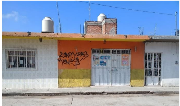
#176 INMUEBLE S/N DE UNA TIENDA DE ABARROTOS DE LA CALLE NICOLAS BRAVO ENTRE EMILIO CARRANZA Y RAYON, ZONA CENTRO, ROMITA, GUANAJUATO. EN LA ESQUINA HAY UNA OFICINA DE PROYECTOS PARA COCINA.
