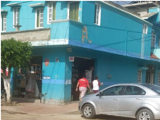
# 330 EN LA PARTE EXTERIOR DE UN NEGOCIO DE ABARROTES, UBICADO EN CALLE MARIANO ESCOBEDO, NUMERO 59, ZONA CENTRO DE ROMITA, GUANAJUATO
