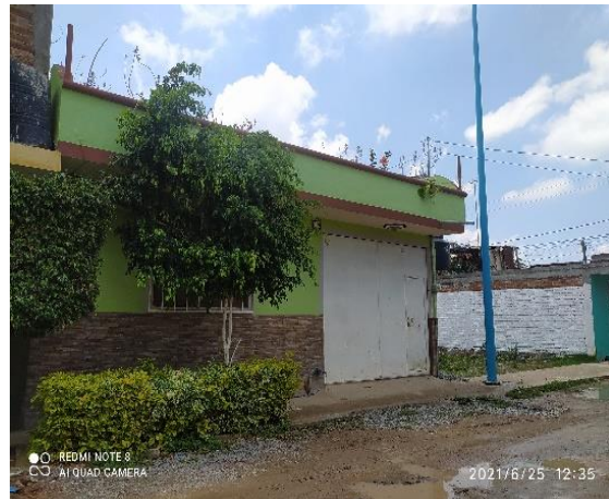
# 371 CALLE LAUREL, ESQUINA CALLE ALAMO, COLONIA CAMPO VERDE 2DA SECCION, ROMITA, GTO.
