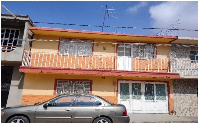
# 152 Casa marcada con el número 4, de la calle Villagómez, zona centro, Romita, Gto.
