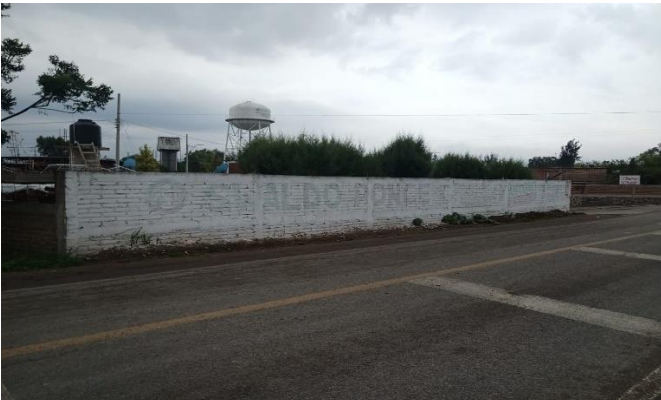
#59 SOBRE LA CARRETERA TEJAMANIL - VISTA HERMOSA, SOBRE LA SEGUNDA ENTRADA PARA ACCESAR A LA COMUNIDAD DE TEJAMANIL,
