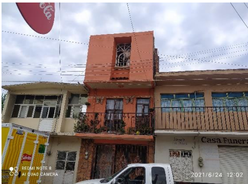
# 378 CALLE ECHEVERRIA, ESQUINA CON 5 DE FEBRERO, ZONA CENTRO DE ROMITA, GTO.
