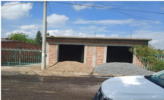
#299 EN LA PARTE SUPERIOR DE UNA FINCA EN CONSTRUCCION, UBICADA A UN COSTADO DEL JARDIN PRINCIPAL DE LA COMUNIDAD DE LA GAVIA DE RIONDA, ROMITA, GUANAJUATO
