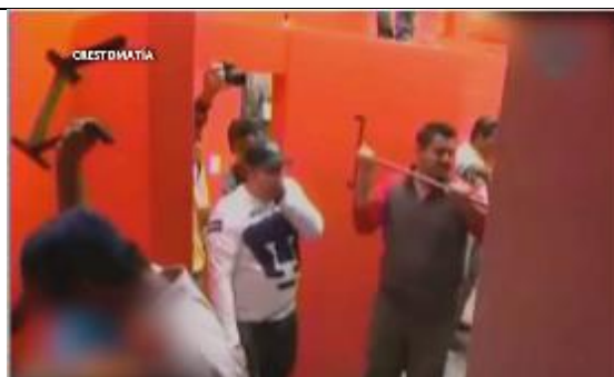
Se evidencia a seis sujetos dentro de un edificio, de los cuales dos tienen objetos metálicos en sus manos, uno de ellos aparentemente rasgando la pared.
