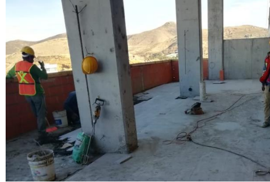
Colocación de acabados en piso
