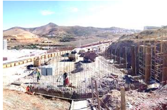
Trabajos de cimentación
