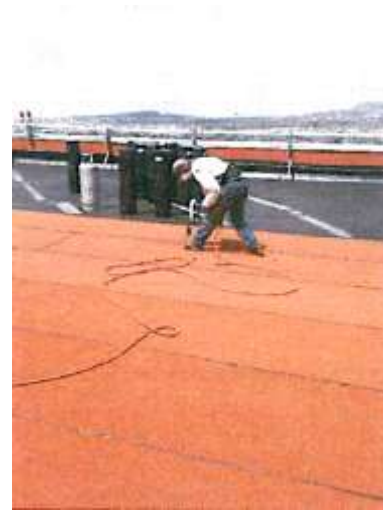
Aplicación de impermeabilizante
