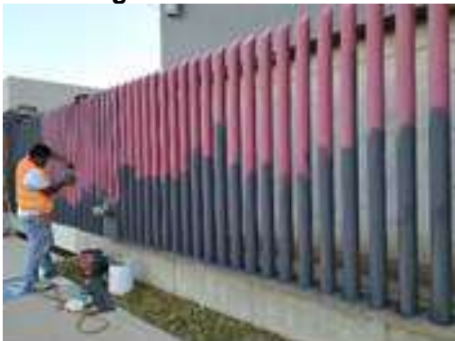
Aplicación de pintura en reja principal
