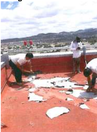
Retiro de impermeabilizante
