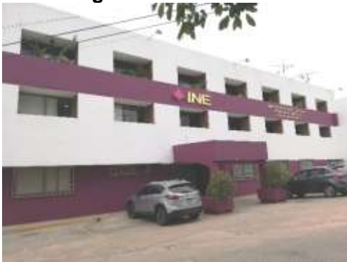
Remozamiento de fachada
