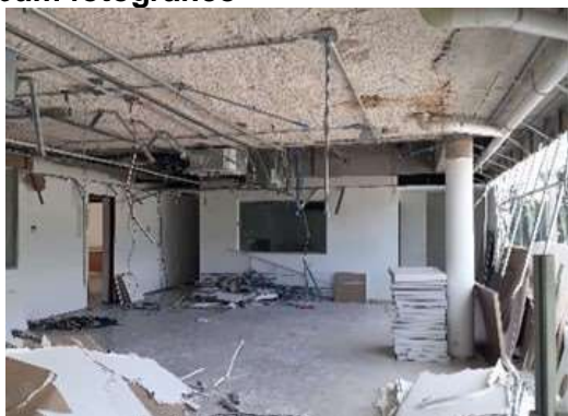
Desmantelamiento de materiales y equipos
