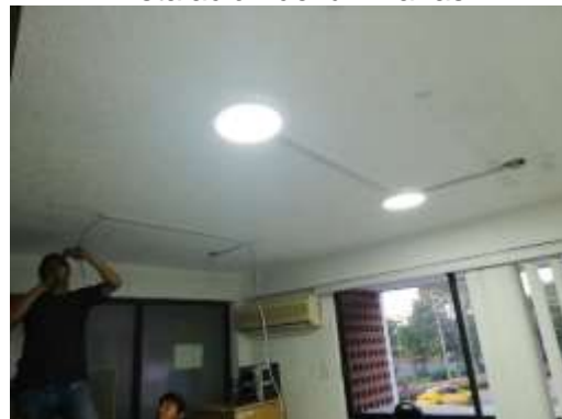
Trabajos de electricidad
