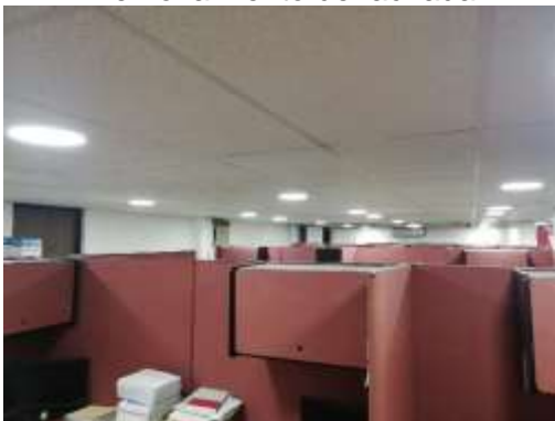
Instalación de luminarias
