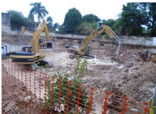
Excavación de terreno
