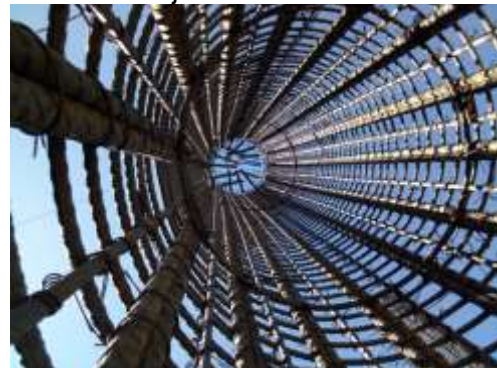
Armado de acero
