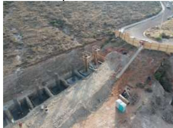
Trabajos de cimentación
