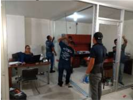
Instalación de cancelería
