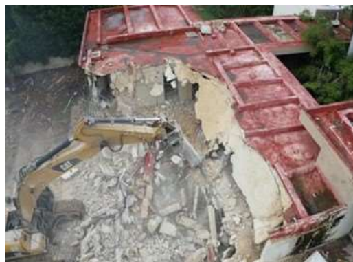
Demolición de edificio existente
