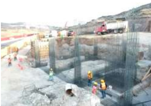
Armado de acero
